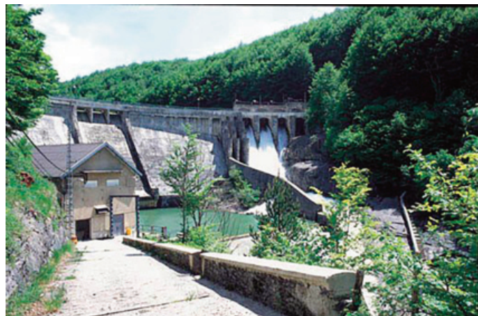
Vista actual de la presa de Irabia vertiendo por el aliviadero de la margen izquierda.
