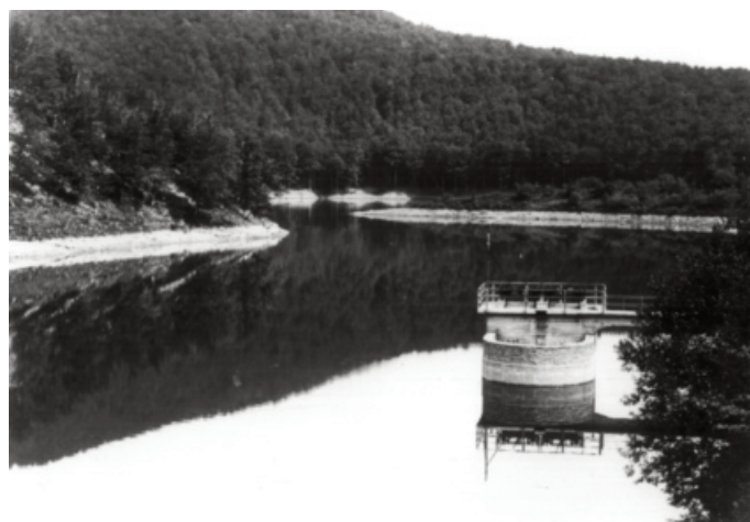
Morning-glory, de la margen izquierda correspondiente al recrecido de 1930.
