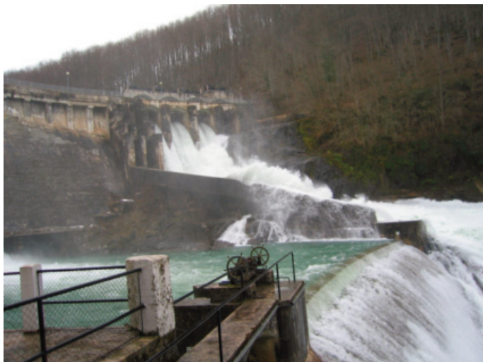
Aliviadero vertiendo en avenida.
